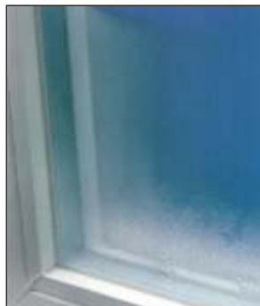
Mit konventionellen Metall-Abstandhaltern ist Kondensation oft gegeben.
