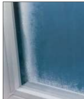
Sogar Abstandhalter mit reduzierter Metalleitfähigkeit übertragen Wärme und so ist Kondensation immer noch ein Faktor.
